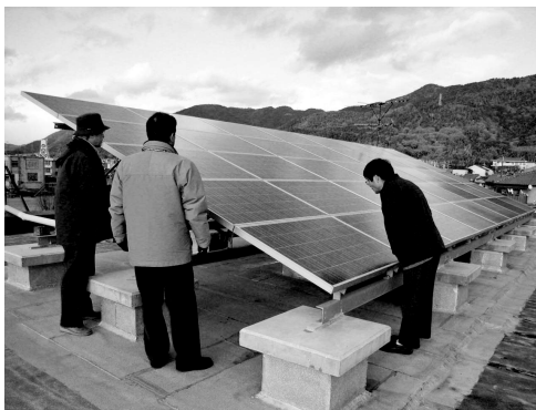
春日野園の太陽光発電パネル パネルの裏には出資された方々の名前が書かれています。
