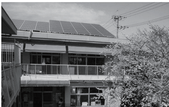
「おひさま発電所」の太陽光発電設備 (京都市北区の大宮保育園)
